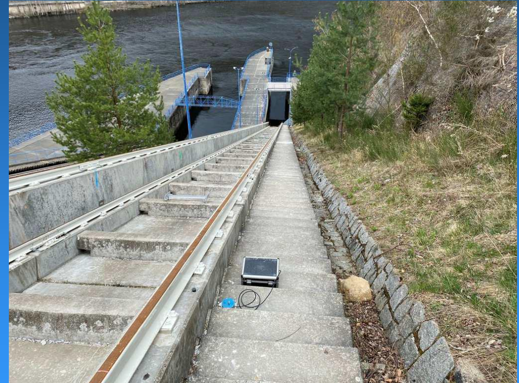
Stanoviště seismografu na lodním výtahu při UM (Bartoš Engineering)
